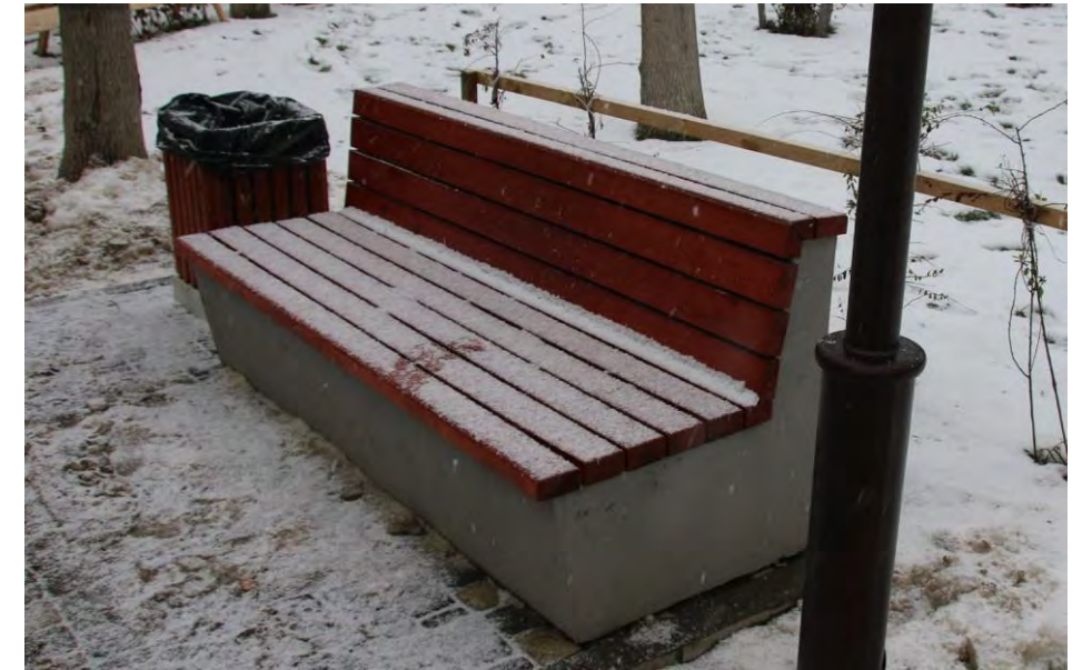
ПЛОХО. Неаккуратно вставлен мусорный мешок
