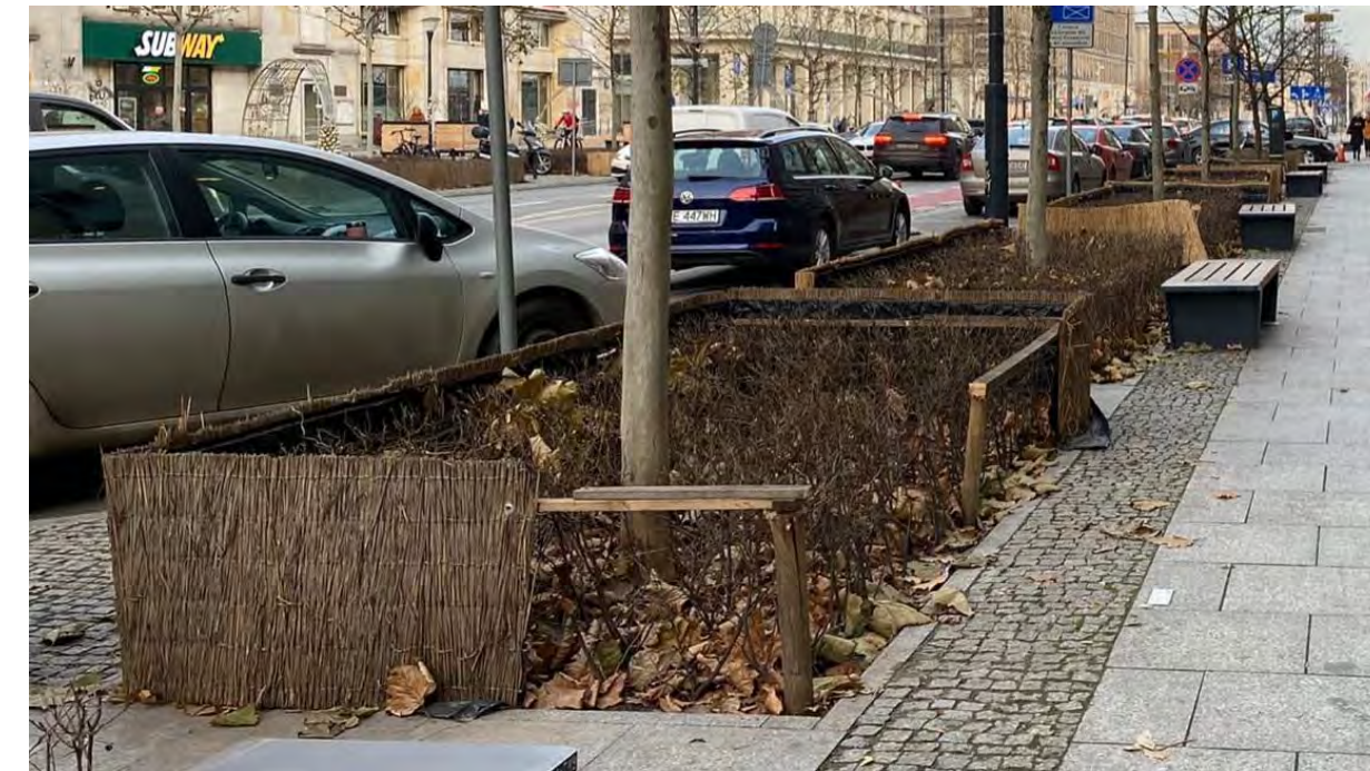
Устройство защитных матов от реагентов со стороны проезжей части на зимнее время, Варшава
