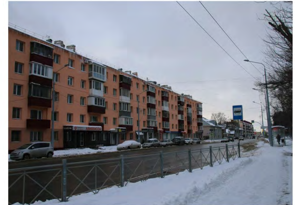
ПЛОХО. Сплошное ограждение препятствует уборке снега
