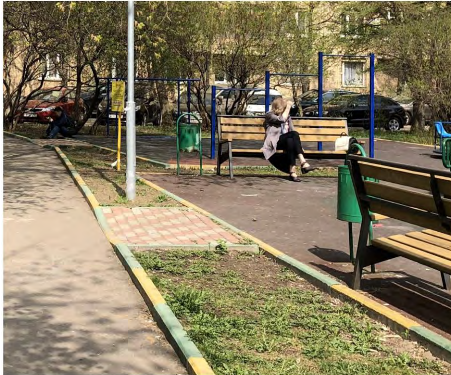
ПЛОХО. Бетонная плитка в зоне двора и бордюр выполнены в различной цветовой гамме и не сочетаются друг с другом
