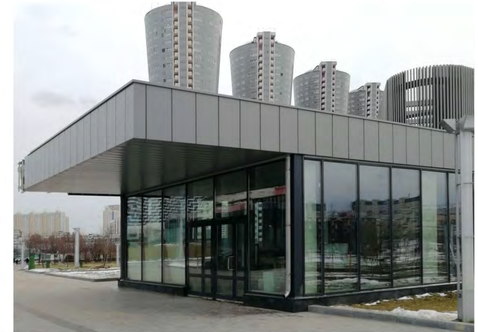
ХОРОШО. Использование остекленных поверхностей
