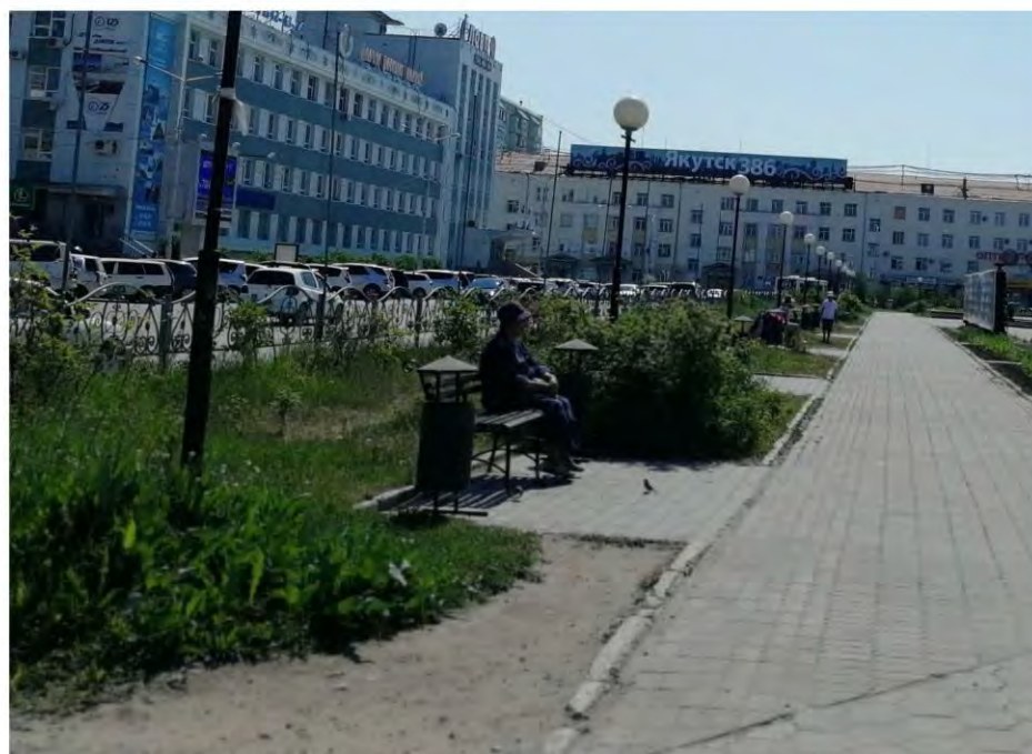
ПЛОХО. Открытый грунт в буферной зоне
