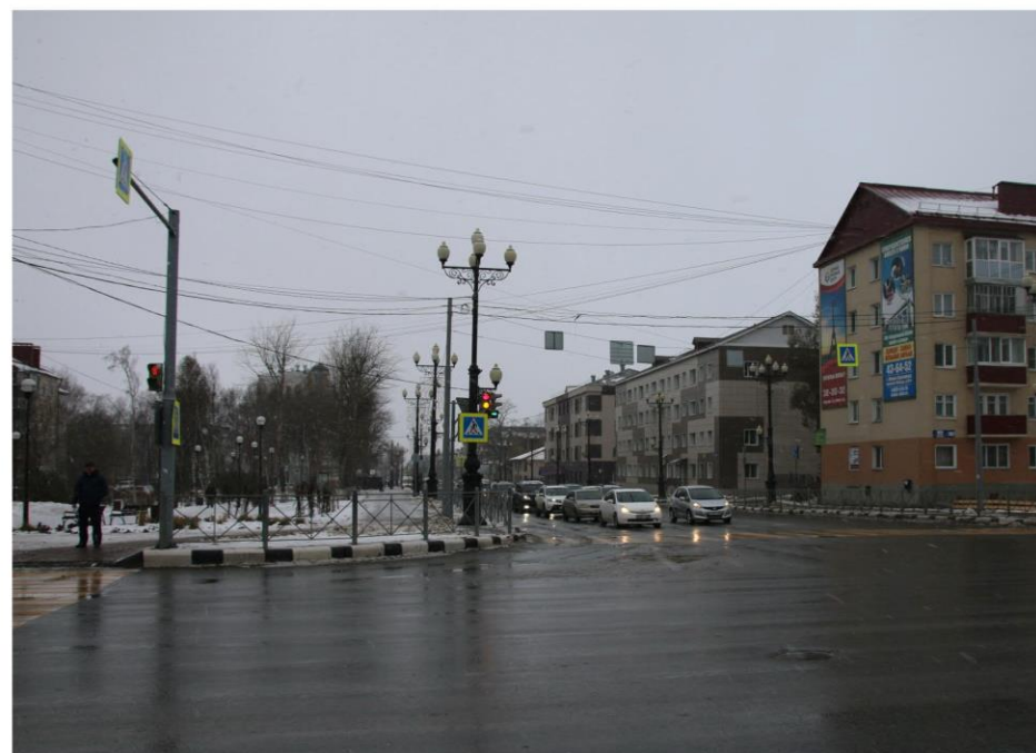
ПЛОХО. Излишнее количество светильников, воздушная прокладка проводов
