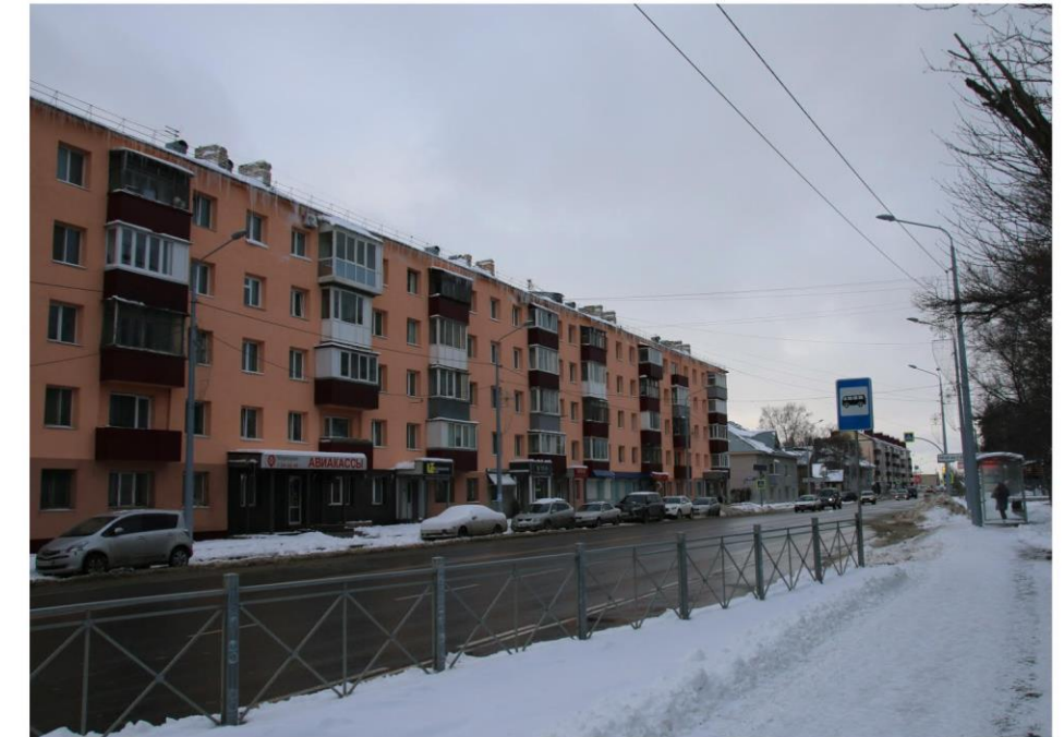
ПЛОХО. Сплошное ограждение препятствует уборке снега
